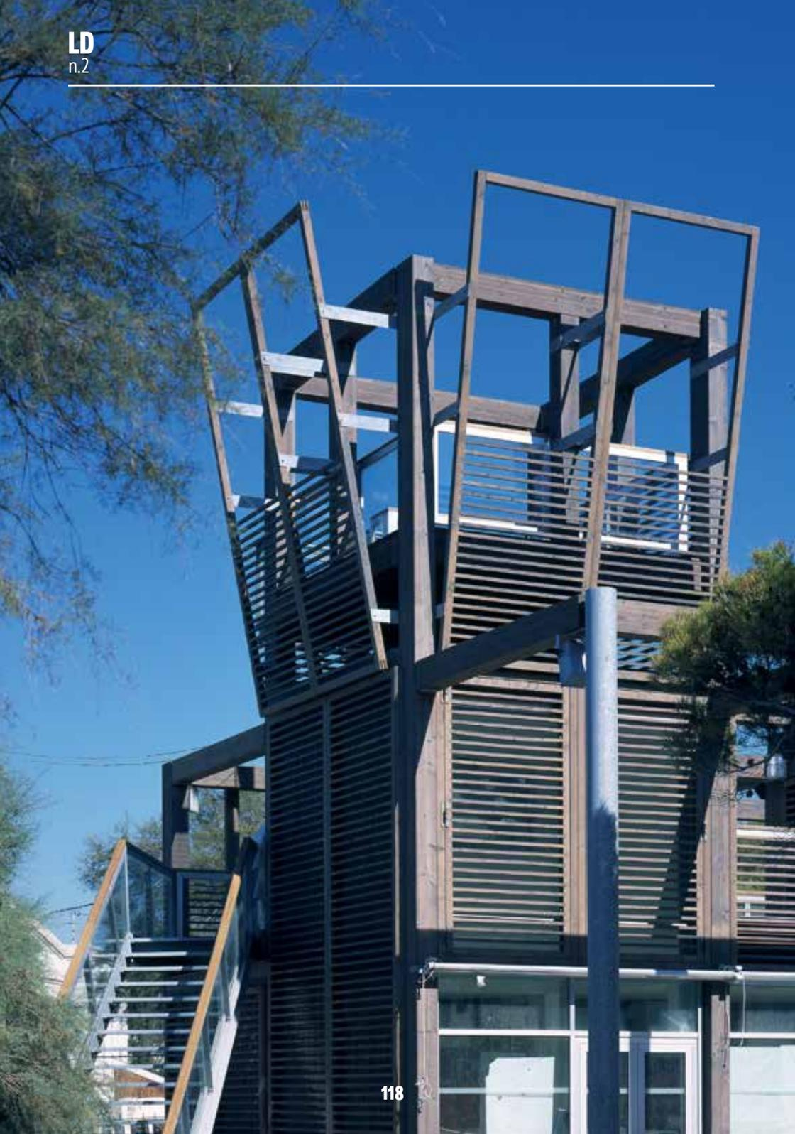
*A lato. Dettaglio delle baracchine di legno lamellare con la torretta panoramica.*
